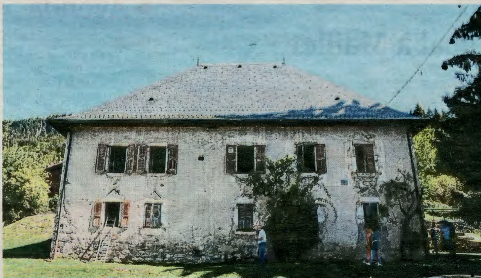
Le bâtiment a été construit au XVIII e siècle. Photo C.O.
